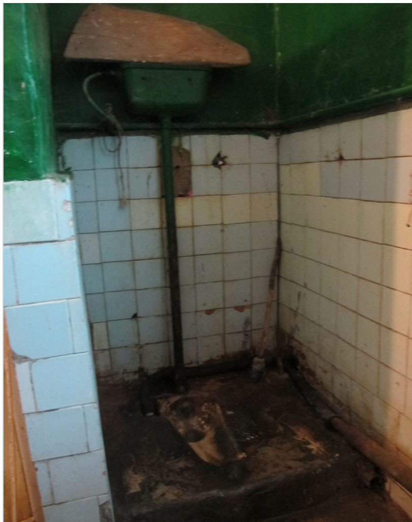
Salles de bains de l'établissement pénitentiaire de Lipcani.
