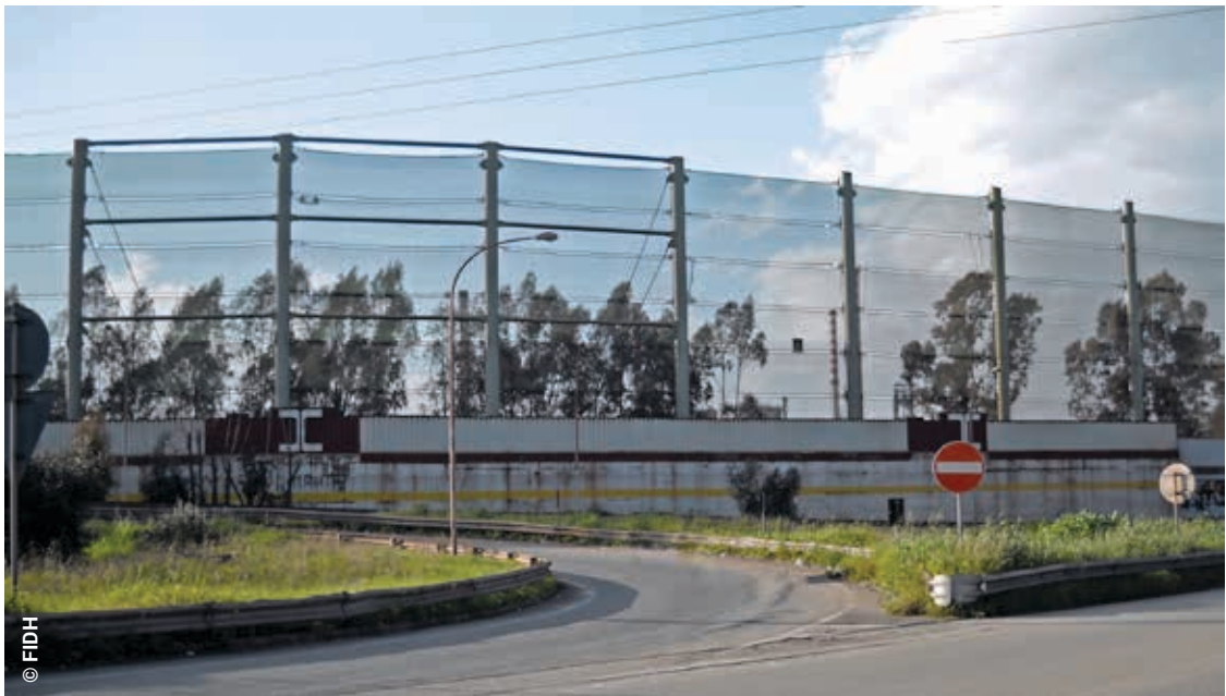
Reti di protezione installate per limitare il diffondersi delle polveri nocive provenienti da ILVA
